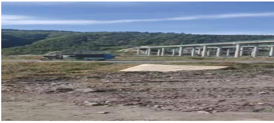
北侧隔空厂房为道路
