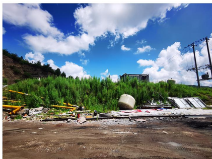
项目东侧钢筋场
