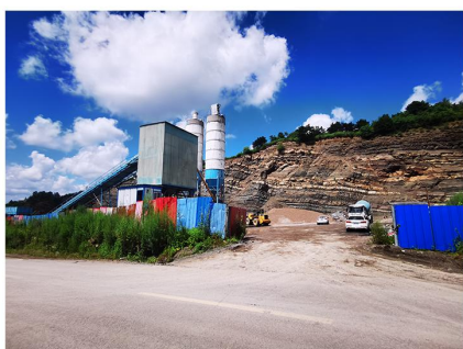
项目主体工程及围挡
